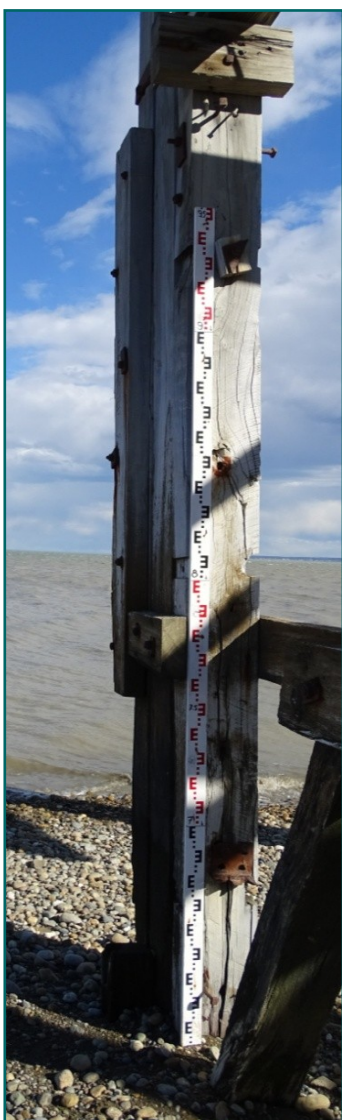
Izquierda - La escala para medir mareas instalada por la Inspección de Obra en el antiguo muelle del Frigorífico Armour, hoy día abandonado.
