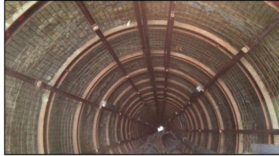
Fotografía 9. Ingreso a interior del pique en JC.
