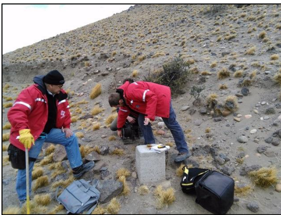
Fotografía 18. Relevamiento y medición de nivel de agua en pozos geotécnicos existentes en margen izquierda de JC.
