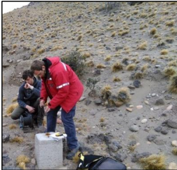
Fotografía 9.4. Relevamiento de pozos de geotécnicos con agua en margen izquierda de JC.
